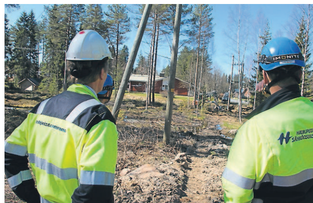
Perinteiset sähköpylväät saavat väistyä jakeluverkon siirtymässä säävarmoihin maakaapeleihin.
