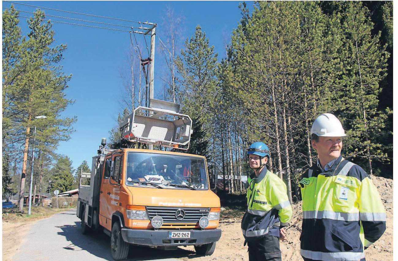
Mikko Martimo (vas.) ja Hannu Hietala esittelevät työmaata, jolla säävarma jakeluverkko on pian valmiina.
