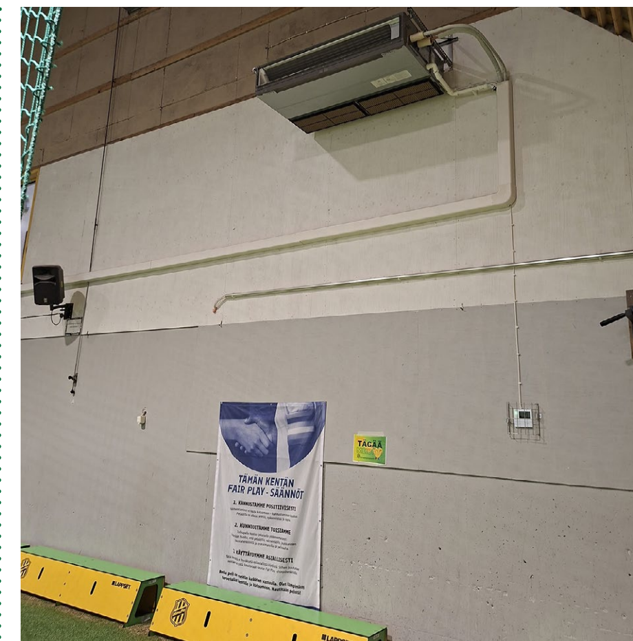
HauPa-halliin asennettiin uusi lämmitysjärjestelmä. Lämmitysjärjestelmä vaihdettiin ekologiseen ilmalämpöpumppulämmitykseen.
