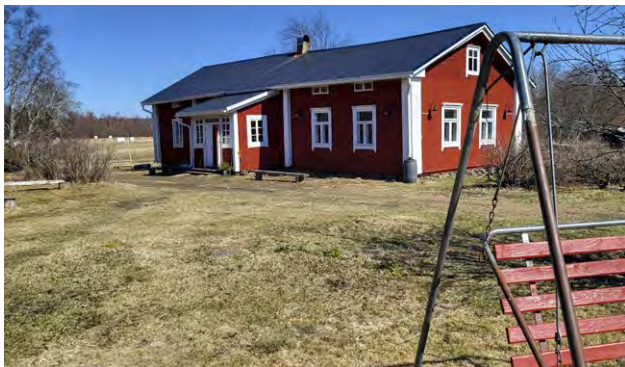
Vanha, 1700-luvulta peräisin oleva punamullalla maalattu asuinrakennus on pihapiiriin aarre. Miia ja Kalevi Ohenojat ovat korjanneet sitä hellällä kädellä ja perinteitä kunnioittaen.
